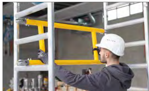
Pulverbeschichtete Geländerrahmen als Querstreben
