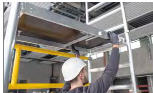
Stabile Plattformen mit Schnellverschlüssen
